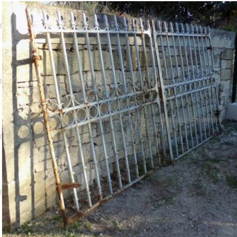
Cet ancien portail de plus de 3 mètres de large en fer forgé plein peint en blanc est doté de 2 vantaux entièrement ajourés. Il est construit en fer forgé de section carrée et de fer plat pour les décors forgés (volutes et tores). Construction rivetée et soudée. Belle patine de rouille en surface. Modèle unique, vendu tel quel avec ses 4 gonds de fixation. La serrure sera à restaurer.
