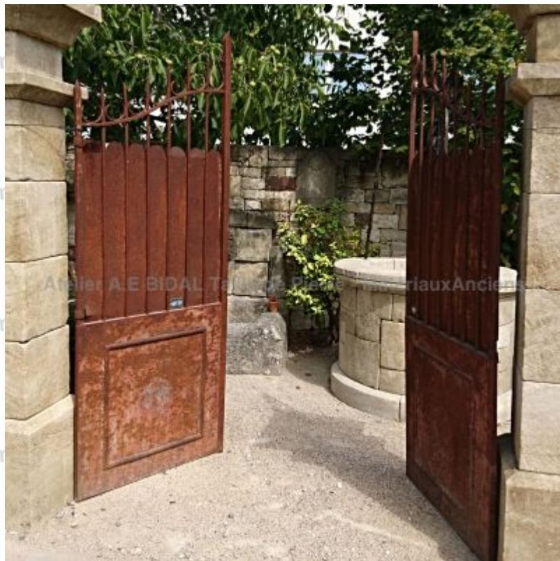
Portail ancien à doubles vantaux en fer forgé. En forme de "chapeau de gendarme", il est tôle aux deux tiers et se terminent par des barreaux ronds en pointes.
