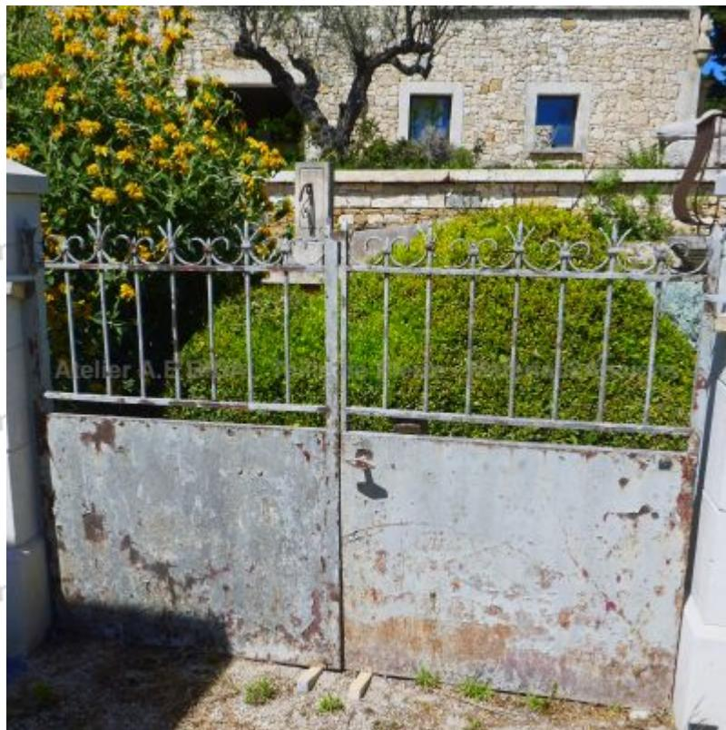
Portail ancien à deux vantaux, en fer forgé riveté. Le soubassement est en panneaux de tôle, le cadre en fer carré et les barreaux en fer ronds surmontés de volutes. Construction rivetée. Belle patine de rouille en surface.
