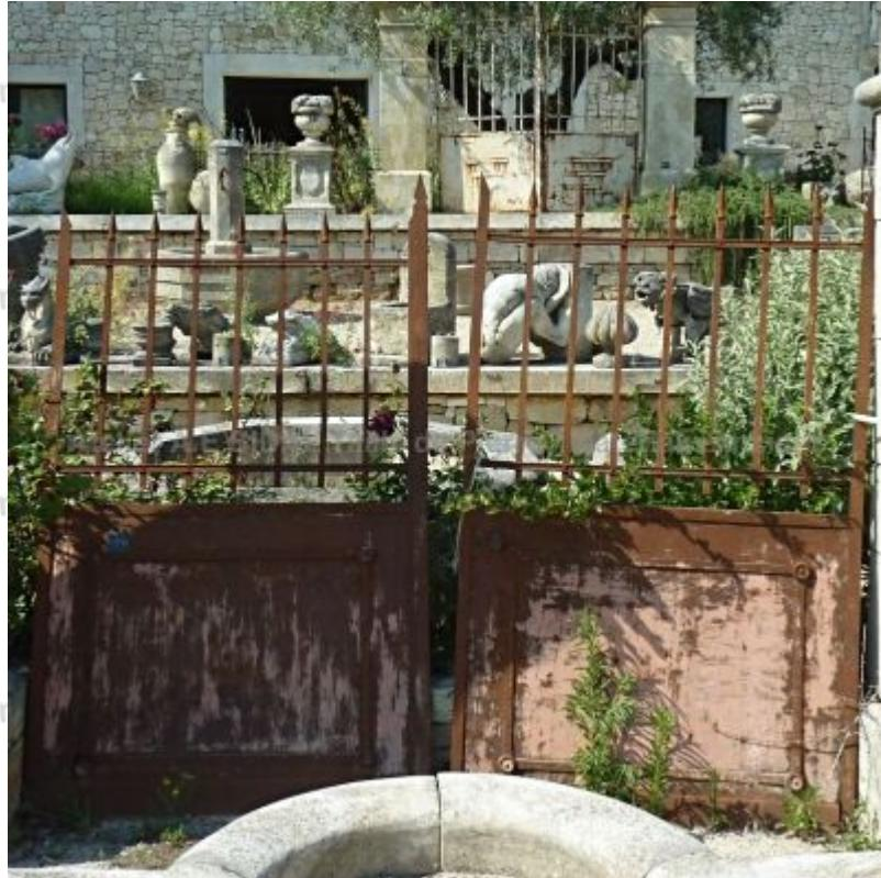
Ancien portail à 2 vantaux en fer forgé semi ajouré. Joli cadre terminé par des médaillons forgés aux extrémités, barreaux en fer plat finis par des pointes fer de lance. Construction rivetée. Belle patine de rouille en surface.
