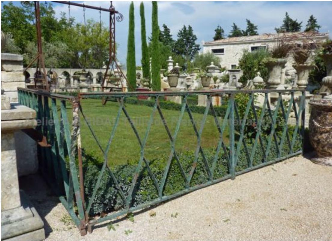
Barrière simple ancienne en fer forgé ajouré. Ce garde-corps se compose de barreaux à fers plats torsadés. Construction rivetée.
